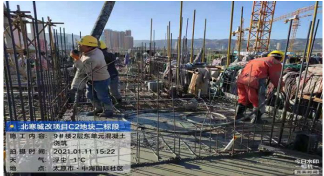
9#楼混凝土浇筑
